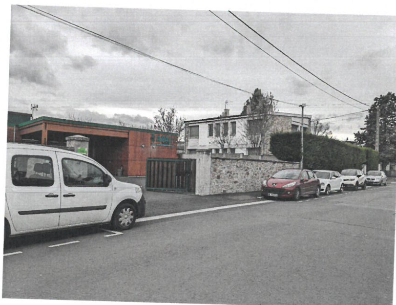
Travaux d'abaissement du trottoir le long du mur d'entrée du CAMSP
