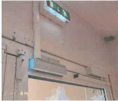
Afin de sécuriser l'entrée dans le bâtiment nous avons installé un verrouillage automatique des portes donnant sur l'extérieur de 22h à 7h. En cas de déclenchement de l'alarme incendie, les portes sont déverrouillées automatiquement par la centrale incendie.
